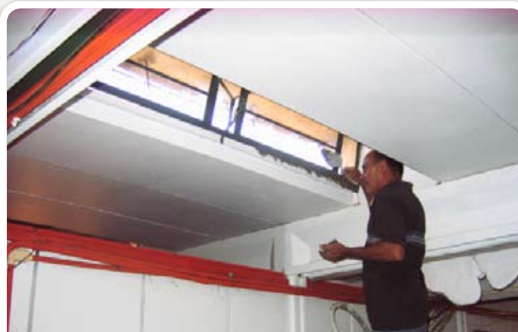
Reforma da Creche Caminho de Luz
